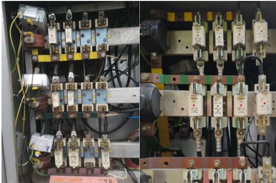
Slika 7. Ugradnja strujnih mjernih transformatora u transformatorske stanice tipa SBTS / SATS
