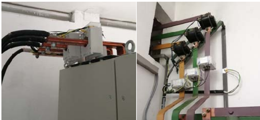
Slika 5. Ugradnja strujnih mjernih transformatora u armiranobetonske transformatorske stanice
