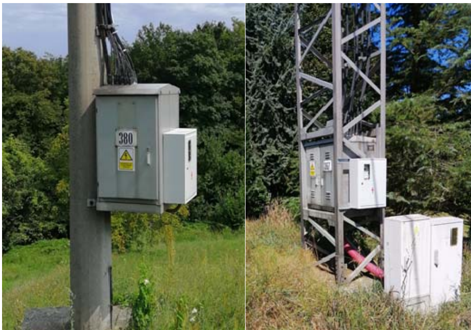
Slika 6. Montaža razvodnog ormara na transformatorske stanice tipa SBTS i SATS
