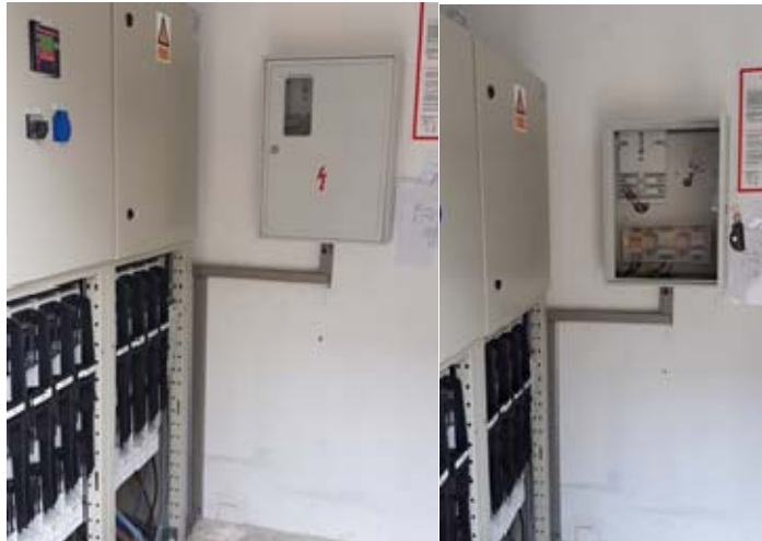
Slika 4. Montaža razvodnog ormara u armiranobetonske transformatorske stanice
